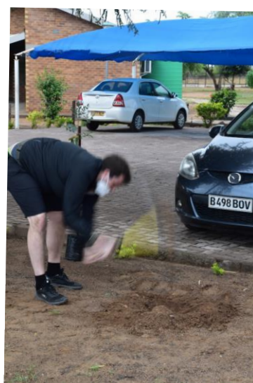
Johan i full färd att gräva en av gröpperna
